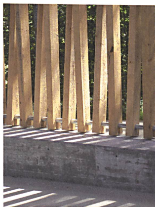
Die schiefen Fassadenhölzer stehen auf einem Metallrohr.
