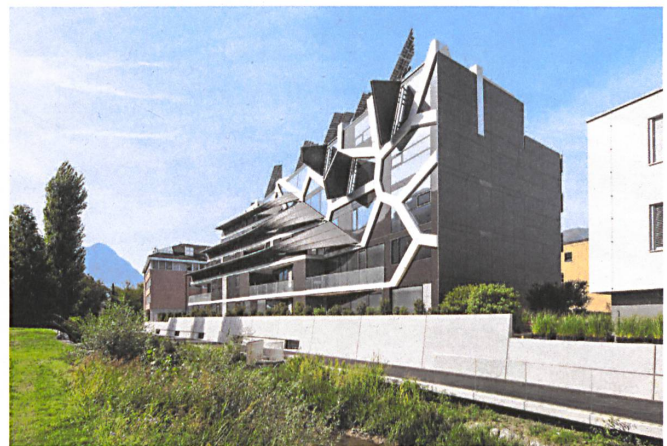
Auch die Form des hellen Stahlgerüsts fanden die Architekten mithilfe des Computers.
