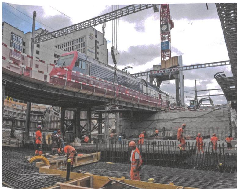
Bauphasen 4 und 5: Hilfsbrücken führen die Züge über die Baustelle für die Quartierverbindung und die Personenunterführung Mitte.
