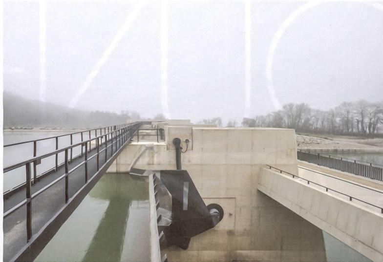
Beim neuen Kraftwerk Hagneck liegt die Wehrbrücke rechts unter dem Stauwasser. Eine massive Brüstung wirkt schützend, zum See ist das Geländer aus Stahl. Der Dienststeg links verbindet die Pfeiler über dem Oberwasser.
