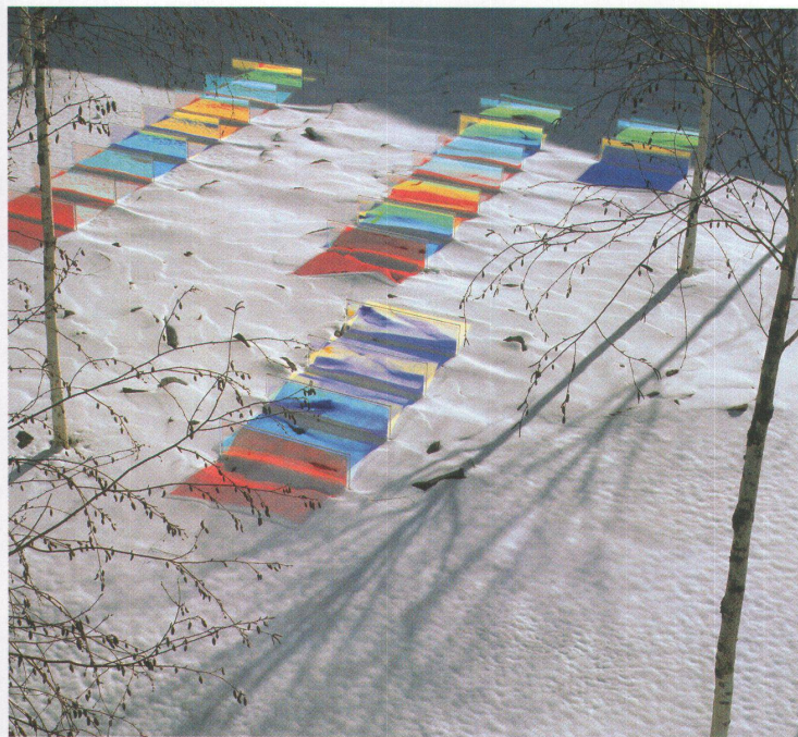
2-5 Le verre est recouvert de lamelles prismatiques qui filtrent certains rayons solaires et les projettent sous forme d'ombres colorées sur les dalles de gneiss.
