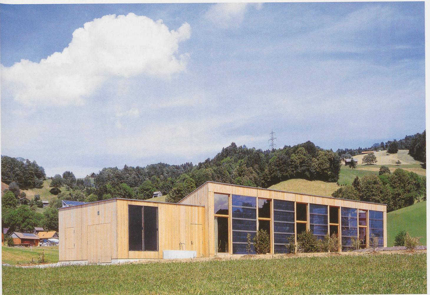
Die Haupträume des Solarhauses III in Ebnet-Kappel sind gegen Süden gerichtet. Die Südfassade ist zu 38 Prozent verglast und zu 62 Prozent mit einer neu entwickelten Solarwand versehen. Die Eigenenergieversorgung liegt bei 95 - bis 100 Prozent; das Haus ist 15 Mal energieeffizienter als der Minergiestandard und 47 Mal effizienter als der SIA-Grenzwert
