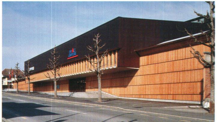
Auf der Strassenseite krägt der verglaste Restaurantriegel über den Eingang heraus
