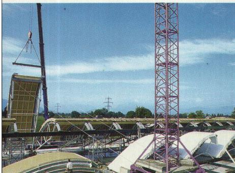
Die unteren Montageeinheiten liegen in der richtigen Lage, eine obere Reihe ist bereits angefügt. Alle Stahlverbindungen sind geschraubt mit Ausnahme der geschweissten Untergurtstösse
