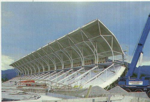
Anfügen einer Montageeinheit. Die Stahlarbeiter haben auf der Baustelle drei Holzelemente von je 5 x 5 m auf ein Teilelement des Fachwerkträgers geschraubt
