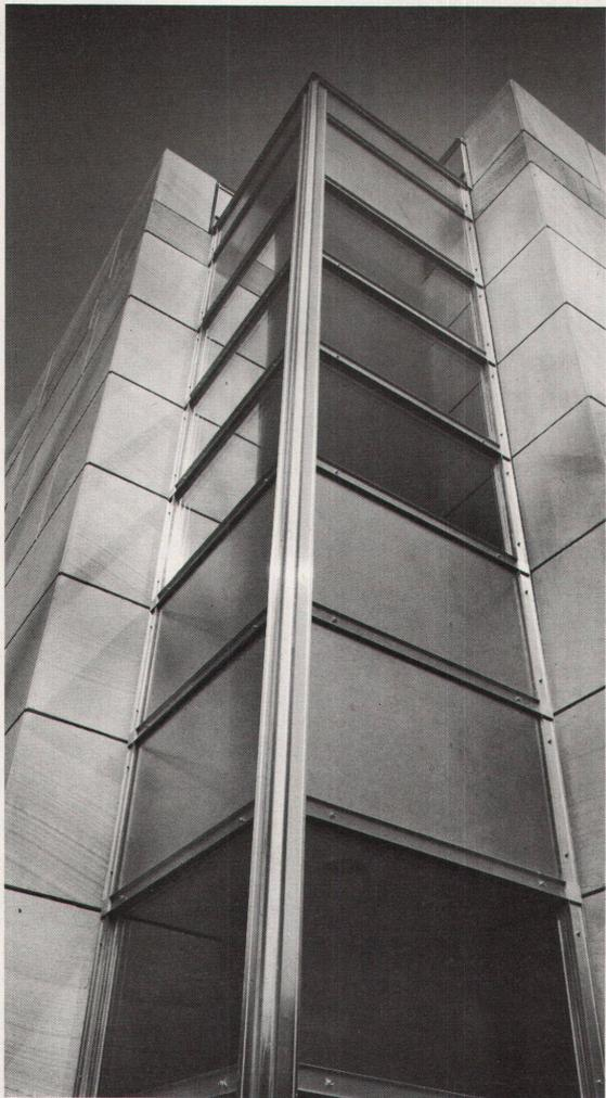
Fensterelemente in Chromnickelstahl und Fassadenverkleidungen in Naturstein verbinden sich zur Einheit. Der Einsatz edler Materialien schliesst Kompromisse aus. Konstruiert und ausgeführt durch die Fassadenbauer aus 3422 Kirchberg.
