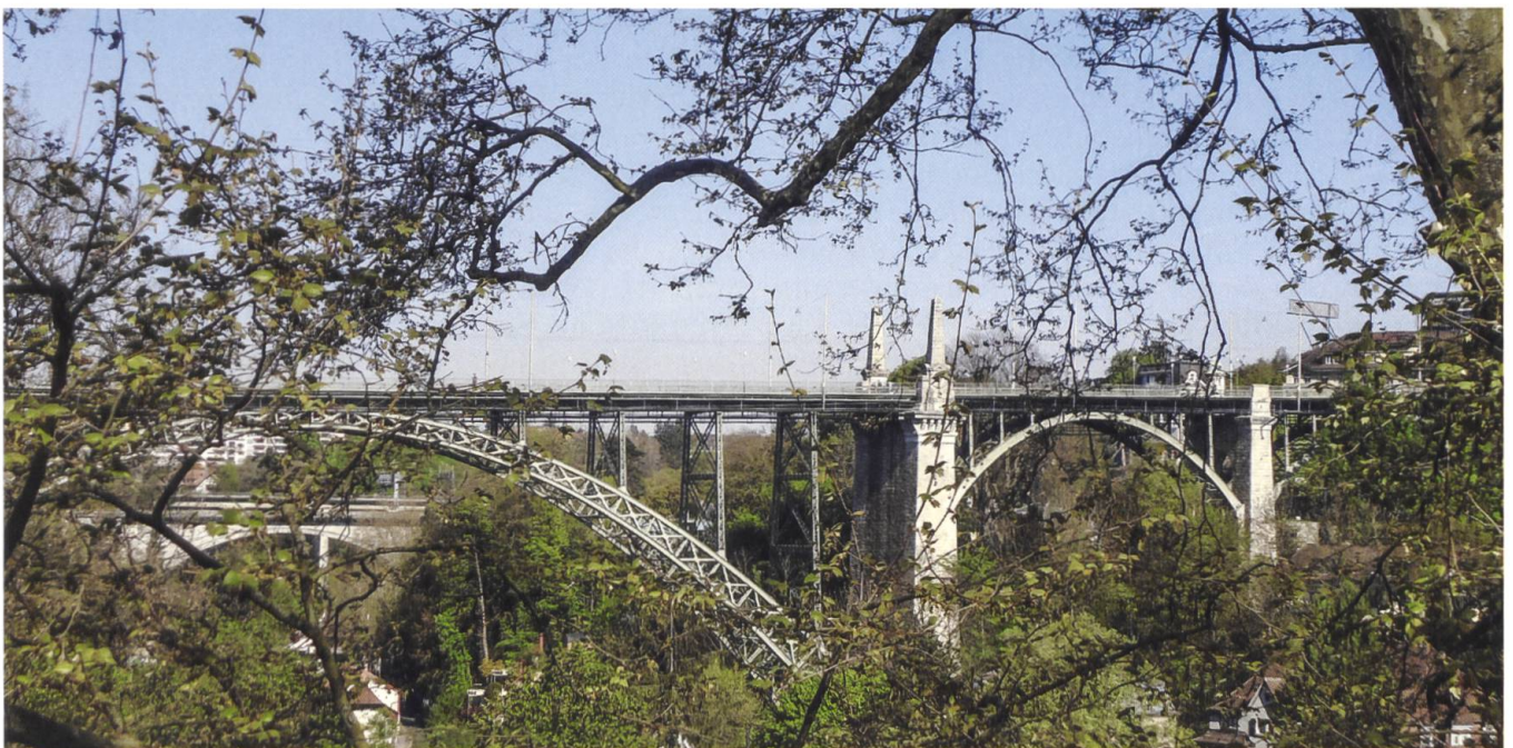
Nach der 1883 erbauten Kirchenfeldbrücke überspannt seit 1898 die Kornhausbrücke das Aaretal. (Foto Daniel Bigler)
