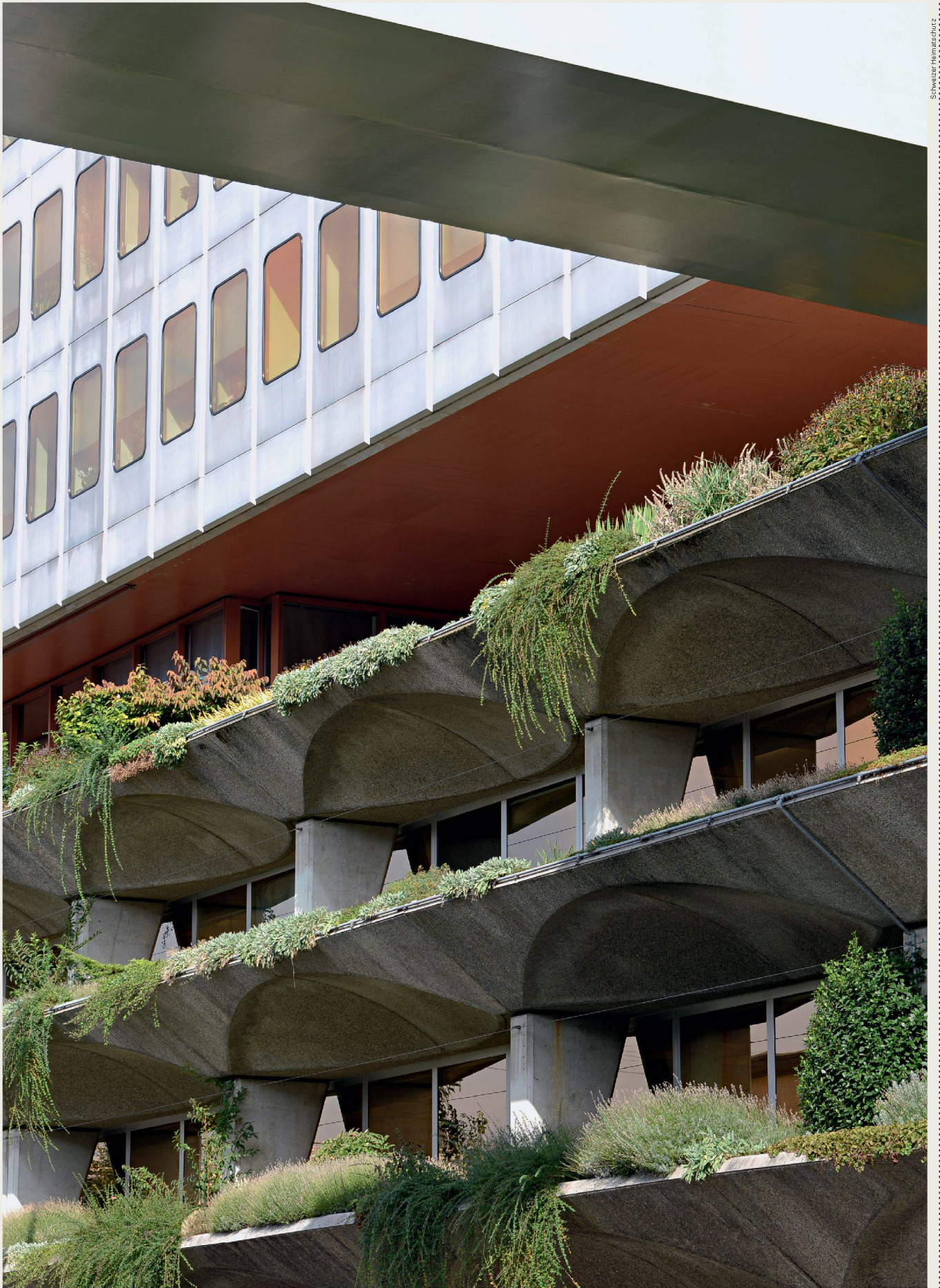
Die Publikation Die schönsten Bauten 1960–75 stellt 50 Bauten aus allen Regionen der Schweiz vor. Eine davon ist der Gebäudekomplex Chauderon in Lausanne, 1969–74.
