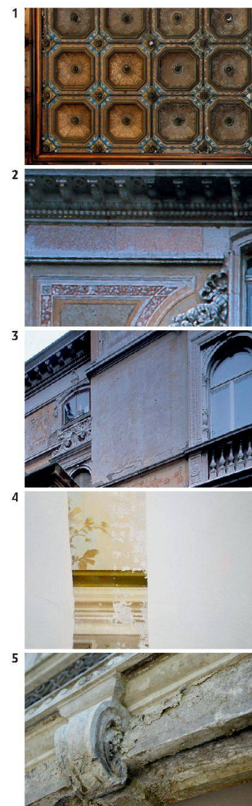
1: le plafond à caissons de la chambre du maître de maison, noirci par la suie
