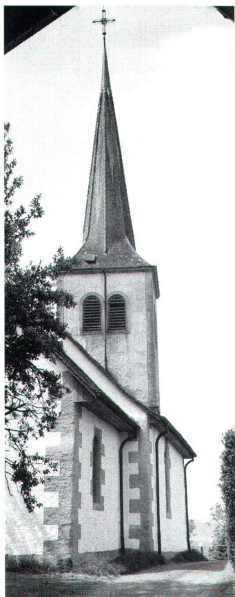
Trotz Widerständen gerettet: die Kirche von Montbrelloz.
