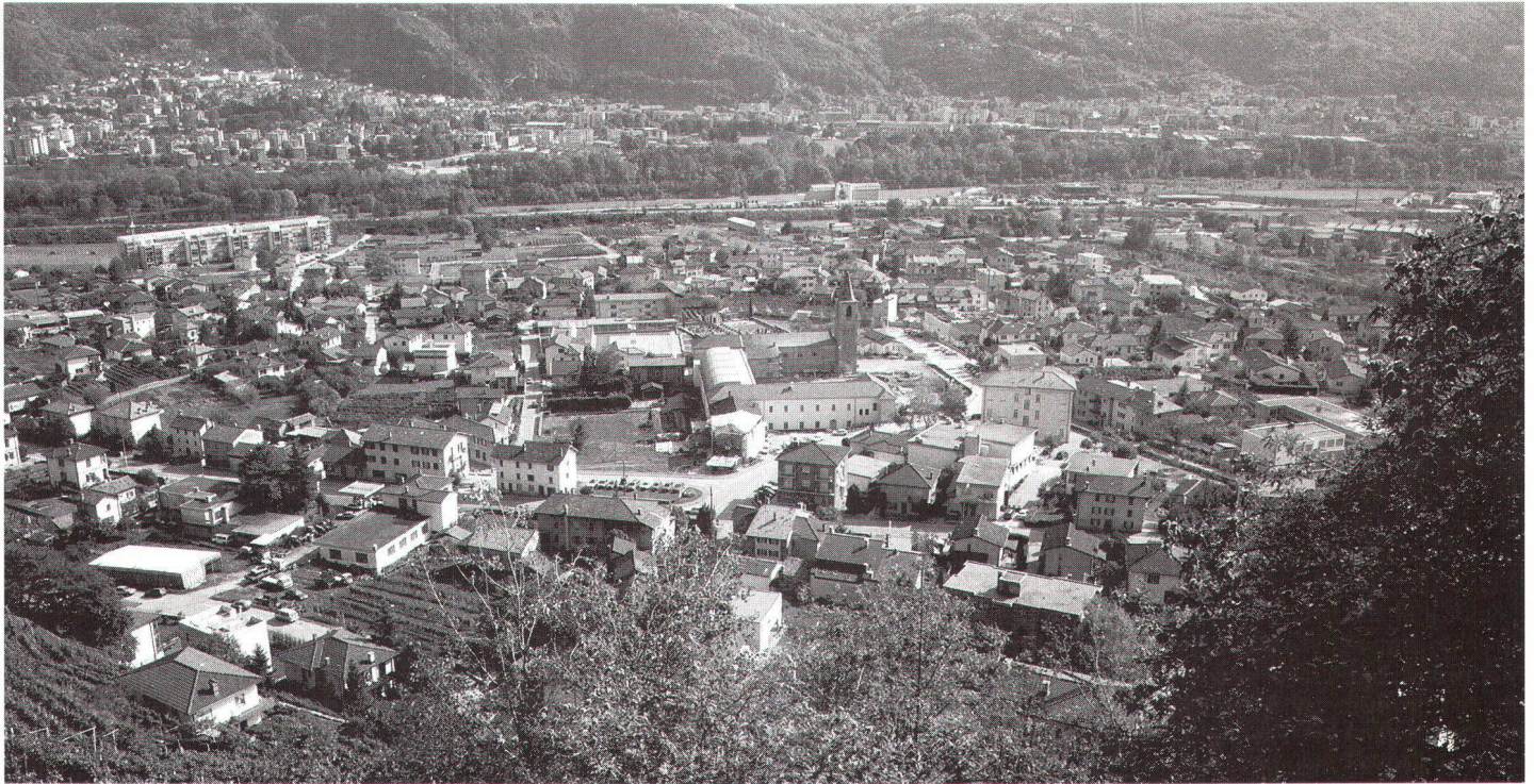
Blick auf den Monte Carasso, wo seit gut zehn Jahren an einem festen baulichen Rahmen für das Dorf gearbeitet wird. (SHS) Coup d'œil sur Monte Carasso, où, depuis une bonne dizaine d'années, on travaille à doter le village d'un solide cadre architectural. (LSP)
