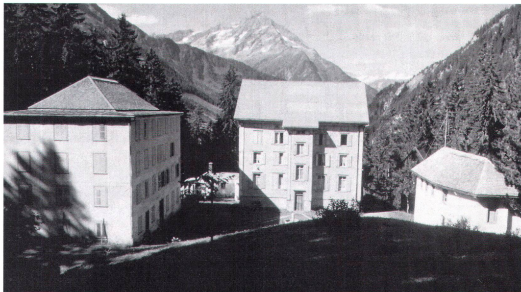
Teilansicht der Hotelkomplexe im Maderanertal nach der Renovation Vue partielle du complexe hôtelier de la Maderanertal UR après rénovation.
