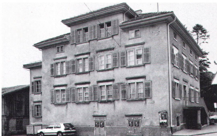
Westseite des ehemaligen Bezirksamtsgebäudes (Bild Gassner) Partie ouest de l'ancien bâtiment officiel du district.
