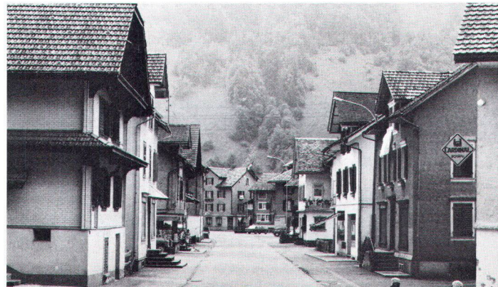
Muotathal – Dorfbild von nationaler Bedeutung (Bild ISOS). Muotathal SZ: village d'importance nationale.
