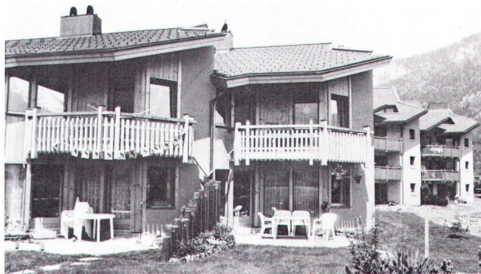
Überbauung «Pfistermatte» in Meiringen: für die Jury der Oberländer Heimatschutz-Jury klar über dem Durchschnitt und bodensparend angelegt (Bild Benninger).
