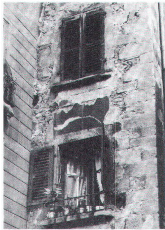
Les chaînes d'angles sont généralement en pierre (ph. Baertschi) Hausecken bestehen meistens aus Steinen
