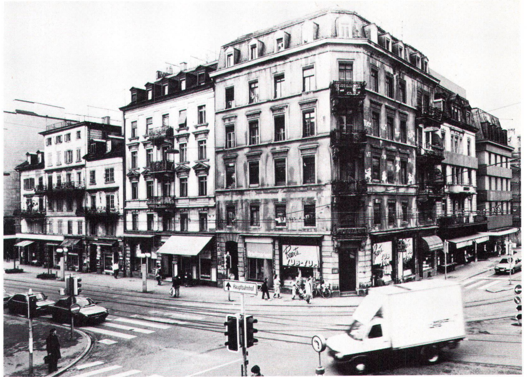
Im Zürcher Stauffacherquartier möchte eine Gruppe von Institutionellen ein neues Zentrum bauen und dafür bestehende Bauten opfern (Bild Stähli)
