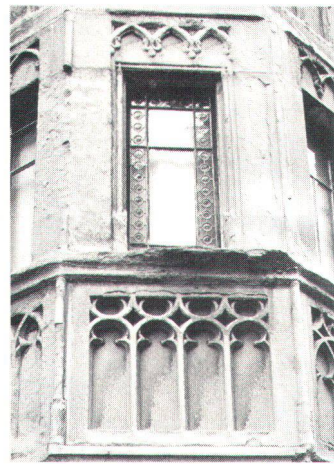
Nicht nur die Wälder, auch die Hausfassaden leiden unter der Luftverschmutzung (Archivbild SHS).
