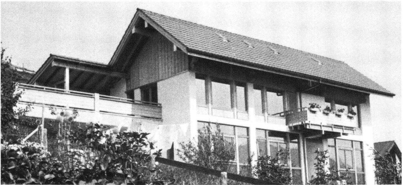
Beispiel einer tadellos integrierten Sonnenenergieanlage in Gonten AR: Kollektor- und Fensterfläche bei diesem Einfamilienhaus wetteifern mit der Klarheit der Südfassaden traditioneller Häuser im Ort (Bild Schäfer).
