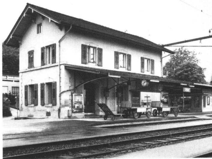
Das Stationsgebäude von Urdorf, einfachster Typenbau der Nordostbahn.
