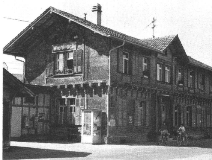
Das Stationsgebäude von Wichtrach, 1859 von Ludwig Maring gebaut, ist heute vom Abbruch bedroht.
