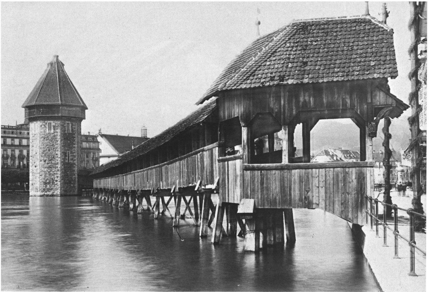
*Ähnliche trapezförmige Pfahljoche mit diagonaler Verstrebung wie auf S. 8 kennzeichnen das System der Luzerner Kapellbrücke. Die durchschnittliche Weite der 28 Brückenöffnungen beträgt 7,65 m. Die geringe Distanz zwischen den einzelnen Pfahljochen erübrigt Spreng- oder Hängewerkkonstruktionen. Südlich des Wasserturmes ruht die Brücke auf quadratischen Steinpfählern, die sich nach oben etwas verjüngen. (Literatur: A. Reinle, Die Kunstdenkmäler des Kantons Luzern, Bd. II, S. 86ff.)*
