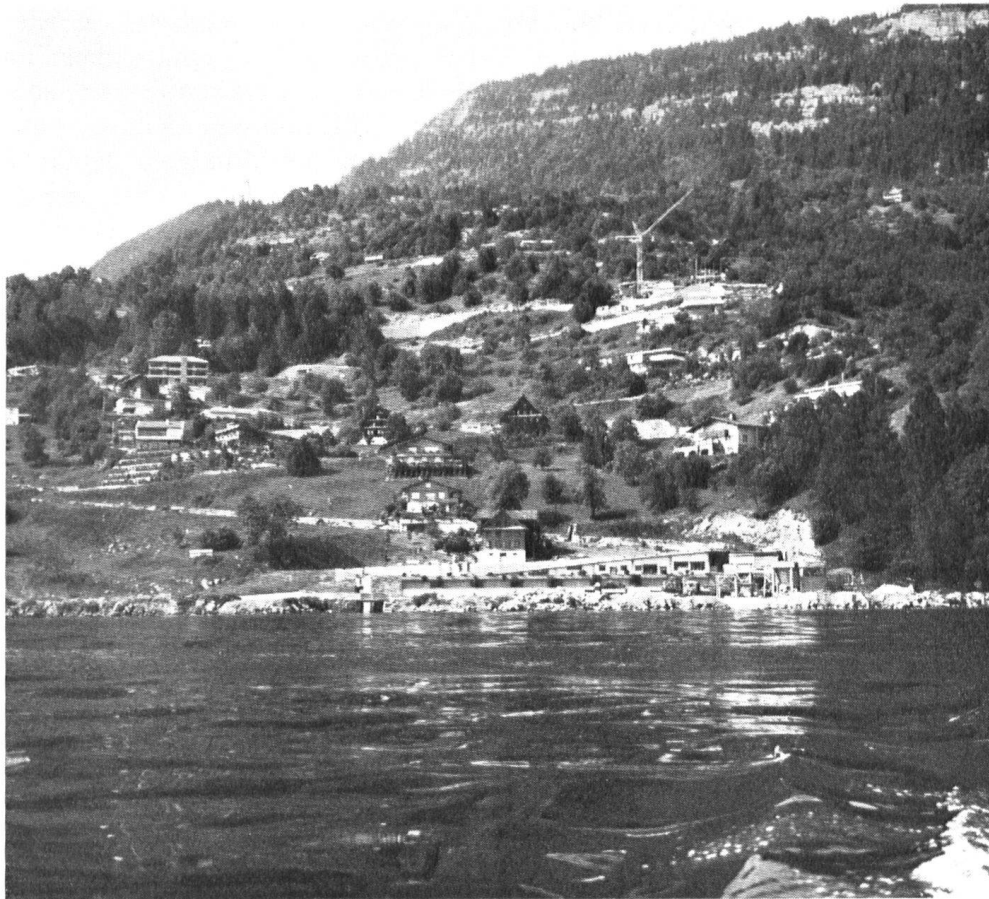
Dans les environs de Weggis les choses se sont sérieusement gâtées, et le port en construction ne contribuera guère à l'embellissement du site.
