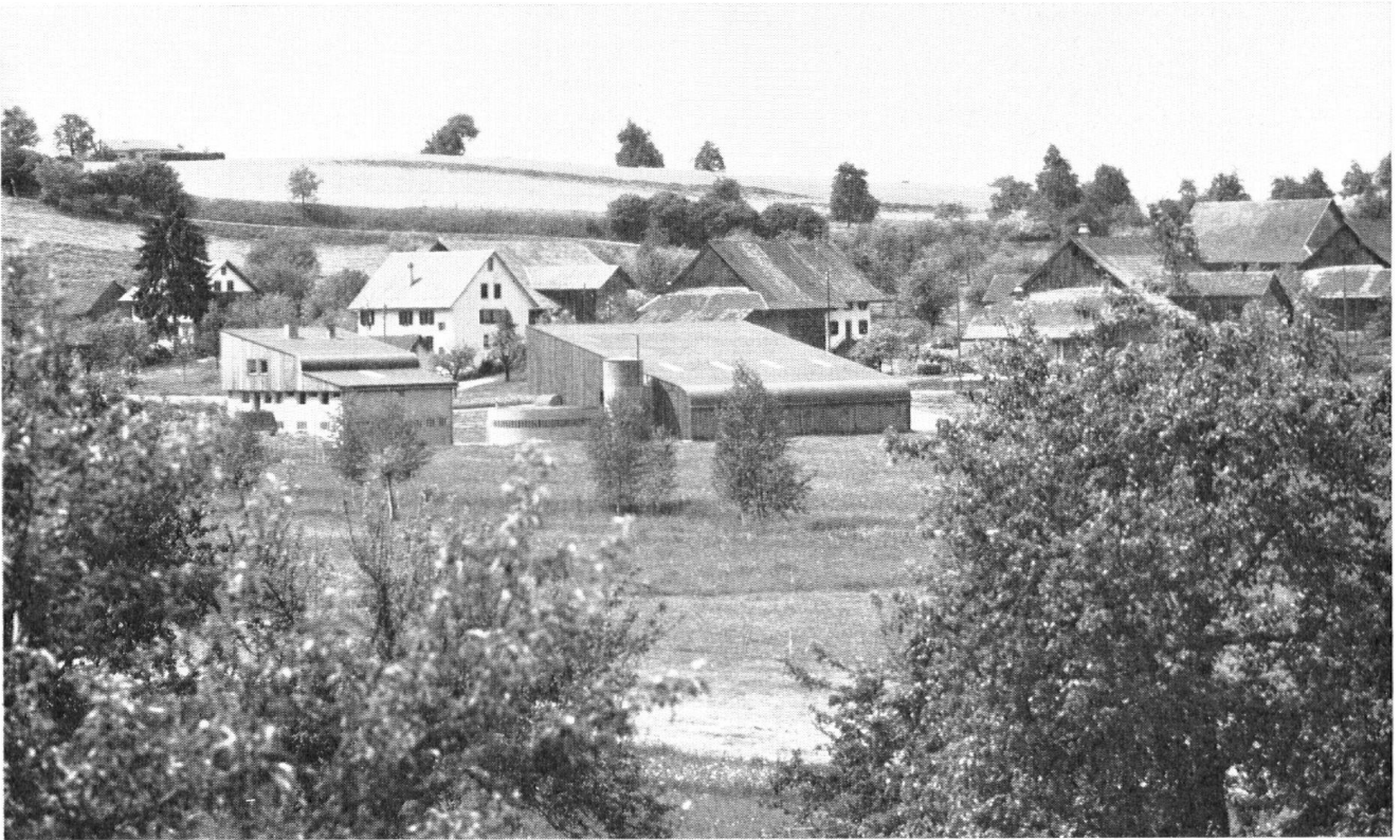
Der vielbesprochene Jonenhof in Rifferswil a. A. ZH, und wie er sich in das alte Dorfbild ‚einfügt‘. Gestalter ist Architekt Heinz Heß, Zürich, Sohn von Architekt Hermann Heß, des architektonischen Betreuers der Baukurse des Schweizer Heimatwerks. Man sieht, wie das Generationenproblem auch im landwirtschaftlichen Bauen seine Rolle spielt.
