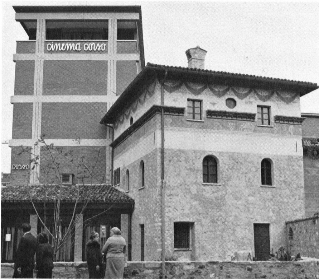
Hochkonjunktur: Ein Beispiel aus Lugano. Die ‚Piccioniaia‘, eines der ältesten Häuser der Stadt (15. Jahrhundert), wurde unlängst mit großen Kosten instand gestellt. Mit großen Kosten ist aber auch das Nachbargrundstück ausgenützt worden. Das Ergebnis ist höchst unbefriedigend.
