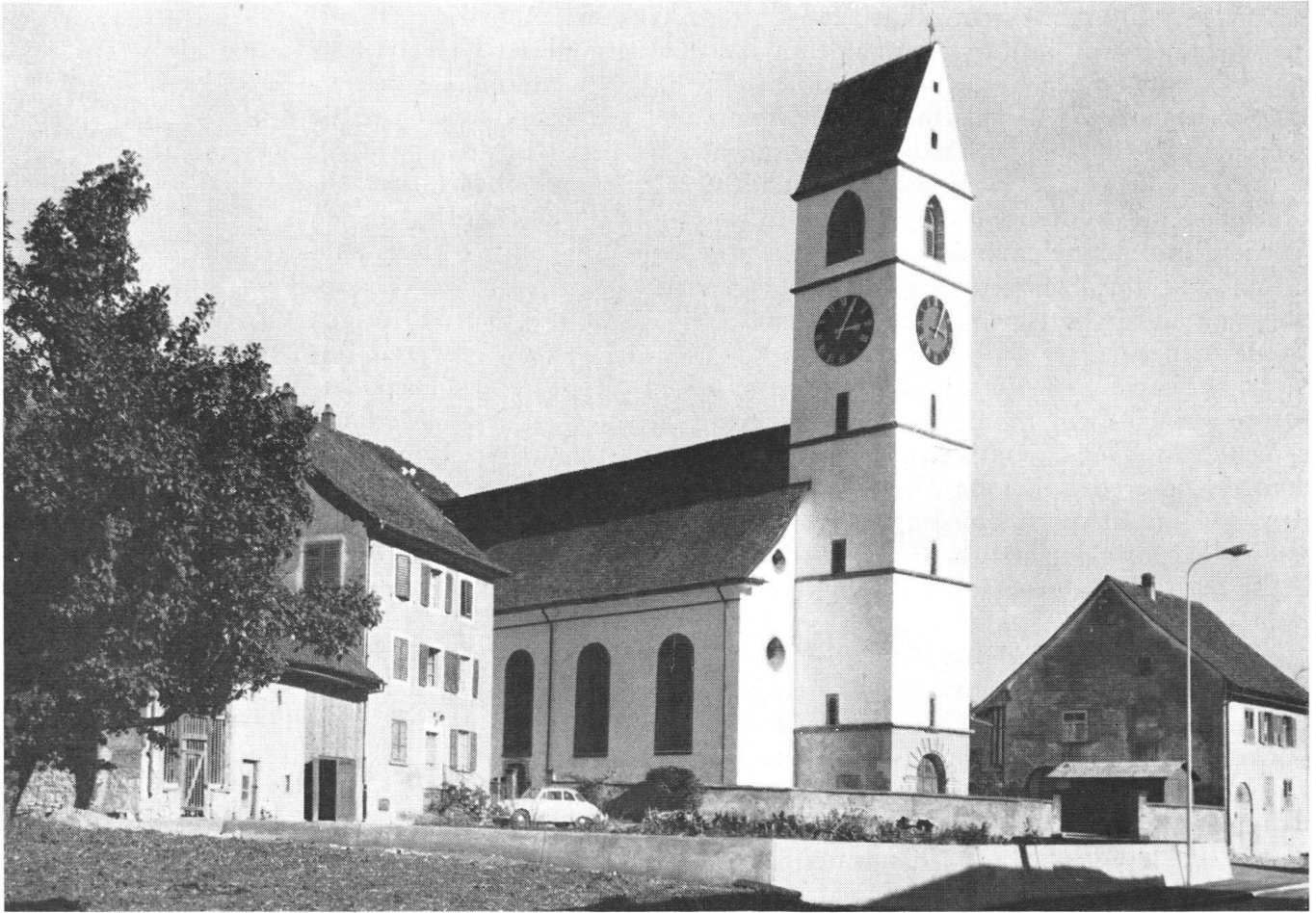
Kirche Mettau. Links Pfarrhaus, rechts Schwesternhaus. Harmonischer Dreiklang.
