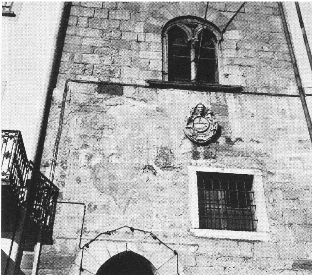
Teilansicht des mittelalterlichen Turmes des Rathauses aus der ersten Hälfte des 14. Jahrhunderts mit Resten wertvoller Fresken; unter dem prächtigen gotischen Fenster mit schönem Maßwerk das alte Gemeindewappen von Morcote. Ärgerlich ist die gedankenlos verlegte elektrische Leitung.
