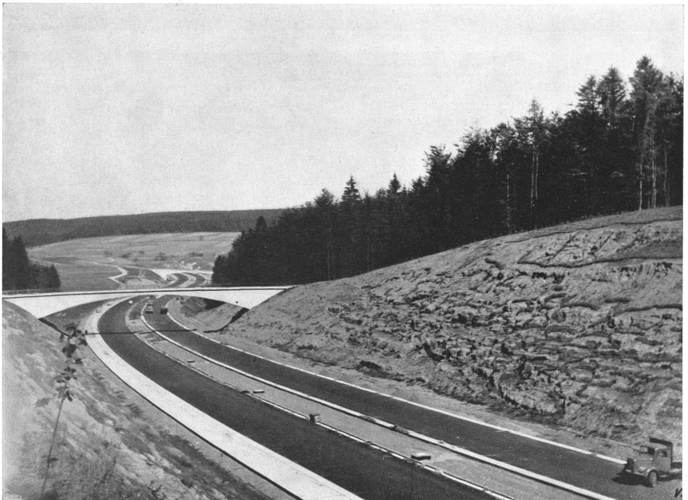
Autobahn Frankfurt-Nürnberg. Weiches Schwingen des Straßenbandes durch das Gelände. Verzicht auf Mauern, selbst bei hohen Böschungen, die sich wieder begrünen werden. Weit gespannte, leichte Brückenform. – Aus „Straße und Verkehr“ Nr. 2/1961.
