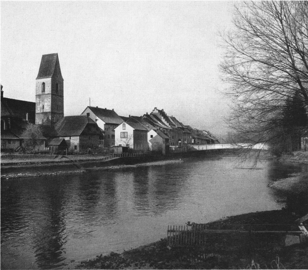
Mellingen an der Reuß. Die alte Holzbrücke, die den Verkehr nicht länger aufzunehmen und zu tra- gen vermochte, wurde durch eine Betonbrücke ersetzt.
