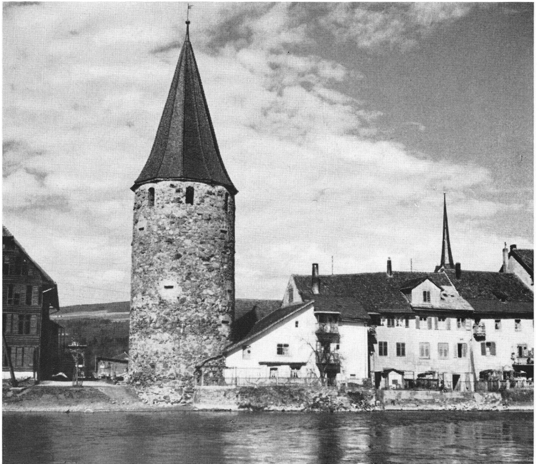
Im mittleren Teil der Flußstrecke, wo die Ufer höher werden, entstanden mittelalterliche Kleinstädte und Flußübergänge. Die beiden Bilder zeigen die erneuerte Holzbrücke bei Bremgarten und den Hexenturm des Städtchens.
