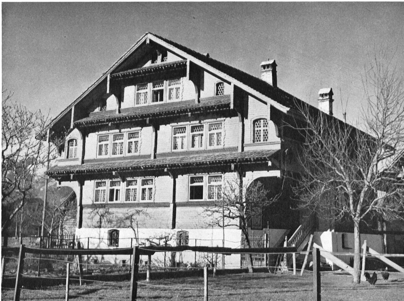
Das «Hostettli» in Stans-Oberdorf nach der Erneuerung.
