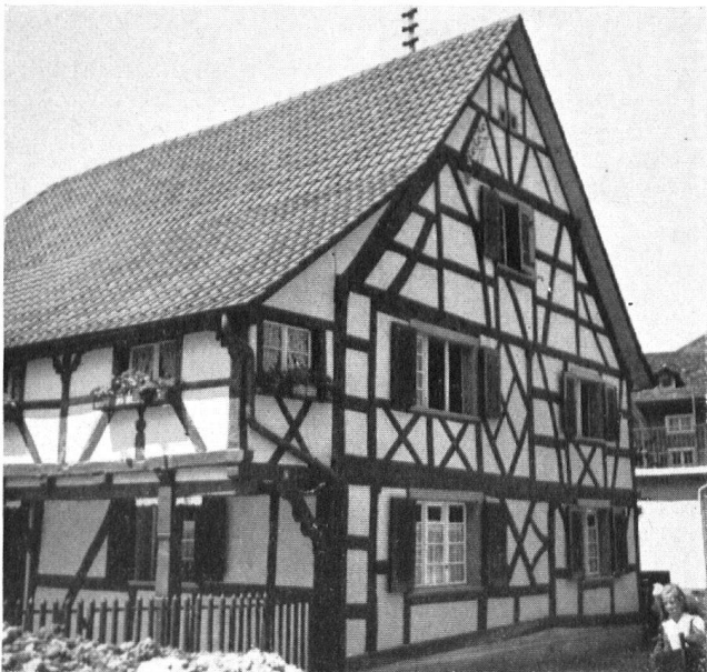
Riegelhaus in Allschwil, ehemals verputzt. An die Freilegung der Riegel leistete die Sektion Baselland einen Beitrag.
