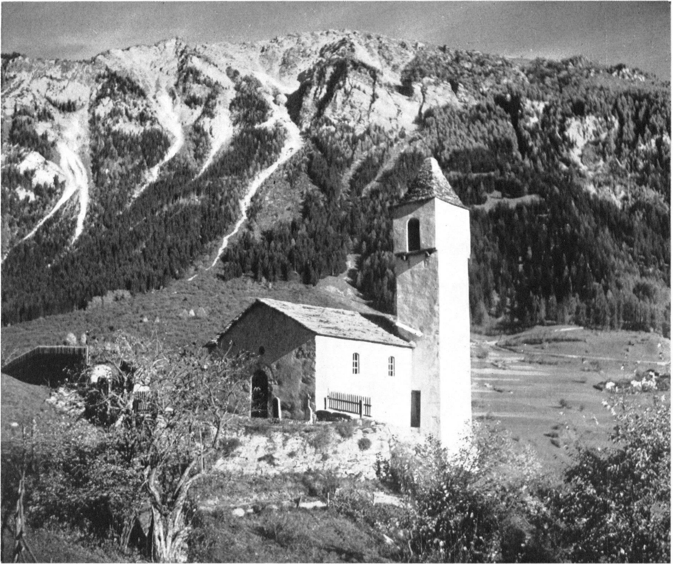
Das romanische Kirchlein von Clugin im Schams (Hinter- rhein). Ein erster Talerzuschuß des Heimatschutzes half mit, die dem Zerfall nahe Kapelle instandzustellen; ein zweiter trug bei, die wertvollen Malereien im Innern zu retten.
