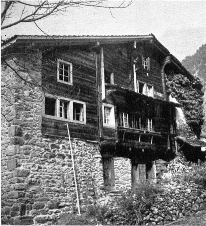
Das in den ehemaligen Stammsitz der Freiherren von Silenen eingebaute Bauernhaus wurde unter Leitung des Heimatschutz-Bauberaters und mit einem Beitrag der Innerschweizer-Heimatschutz-Sektion renoviert.
