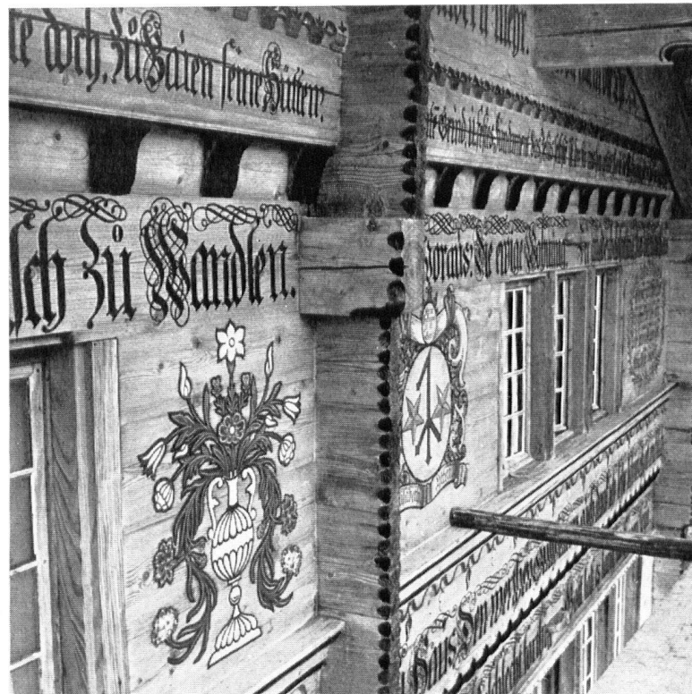
Teilbild der erneuerten Hauswand.
