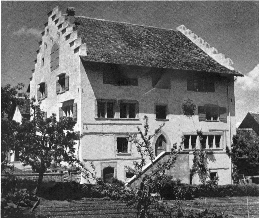
Ein Gemeinschaftswerk des Schweizer und Zürcher Heimatschutzes: die instandgestellten Mühlen zu Richterswil, inskünftig Sitz der Schreinerschule des Schweizer Heimatwerkes. – Der Beitrag des Heimatschutzes und des Kantons Zürich ermutigte das Heimatwerk zum Ankauf des Gebäudes. Den Umbau und die Einrichtung finanzierte es durch eine Sammlung bei Behörden und Privaten. Bauleitung: Arch. M. Kopp, Zürich, Bauberater des Schweizer Heimatschutzes.
