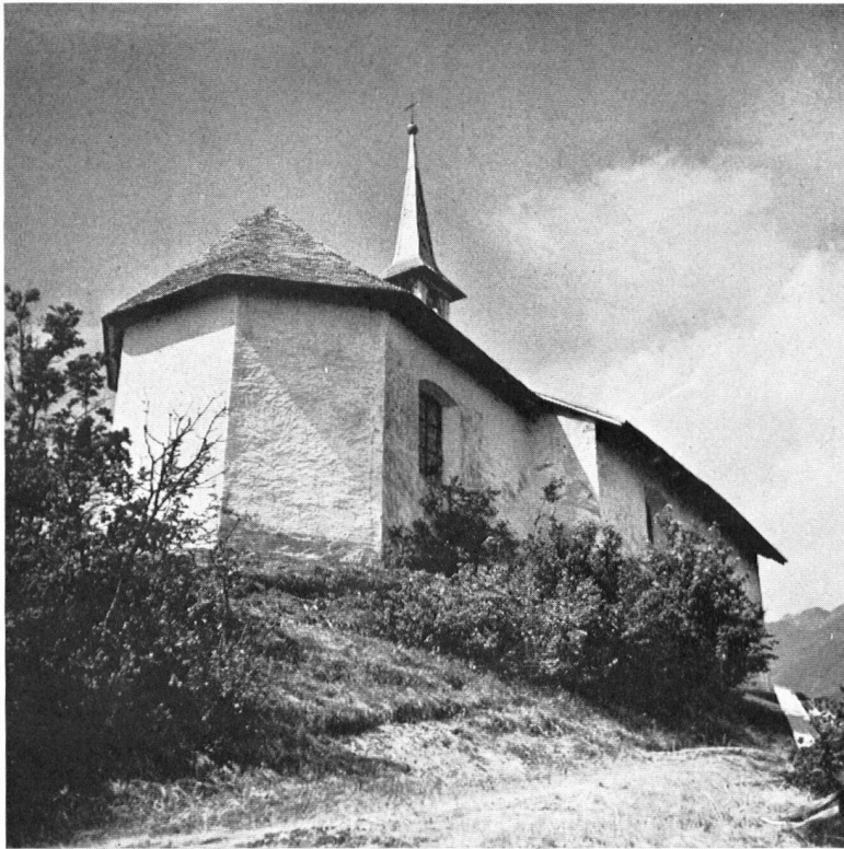
Beispiel einer Talararbeit in der Ostschweiz. Verlassen und zerfallend lag die reizvolle St. Georgskapelle in Pfäfers über dem Taminatal. Schmuck und gefestigt schaut sie heute wieder ins Land.
