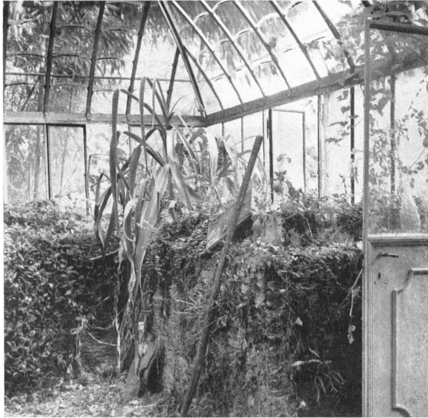
Die Fenster der Treibhäuser sind eingeschlagen, die Anzuchtbeete vom Unkraut überwuchert. Eine vergessene Hakenlilie (Crinum Powelli) ist dank des hereinfallenden Regens munter weitergewachsen. Dans la serre aux vitres cassées, l'eau de pluie a sauvé de l'étouffement un lis asphodèle.
