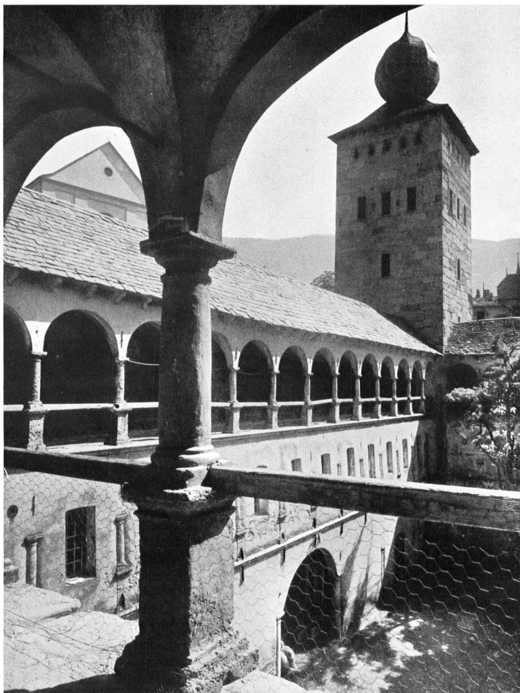
Blick in den Arkadenhof des Stockalper Schlosses. Als zu Beginn des 19. Jh. das Schloß vorübergehend eine geistliche Schule war, wurden die Bogengänge größtenteils zugemauert, um Schlafkammern für die Schüler zu gewinnen. Auf unserem Bild ist der immer noch zugemauerte Arkadengang im 1. Stock deutlich sichtbar. Au début du XIXme siècle, un institut pédagogique s'installa dans le château. Il fallut des dortoirs et l'on ne trouva rien de mieux que de les prendre sur la galerie du premier étage. Il loggiato del castello Stockalper.
