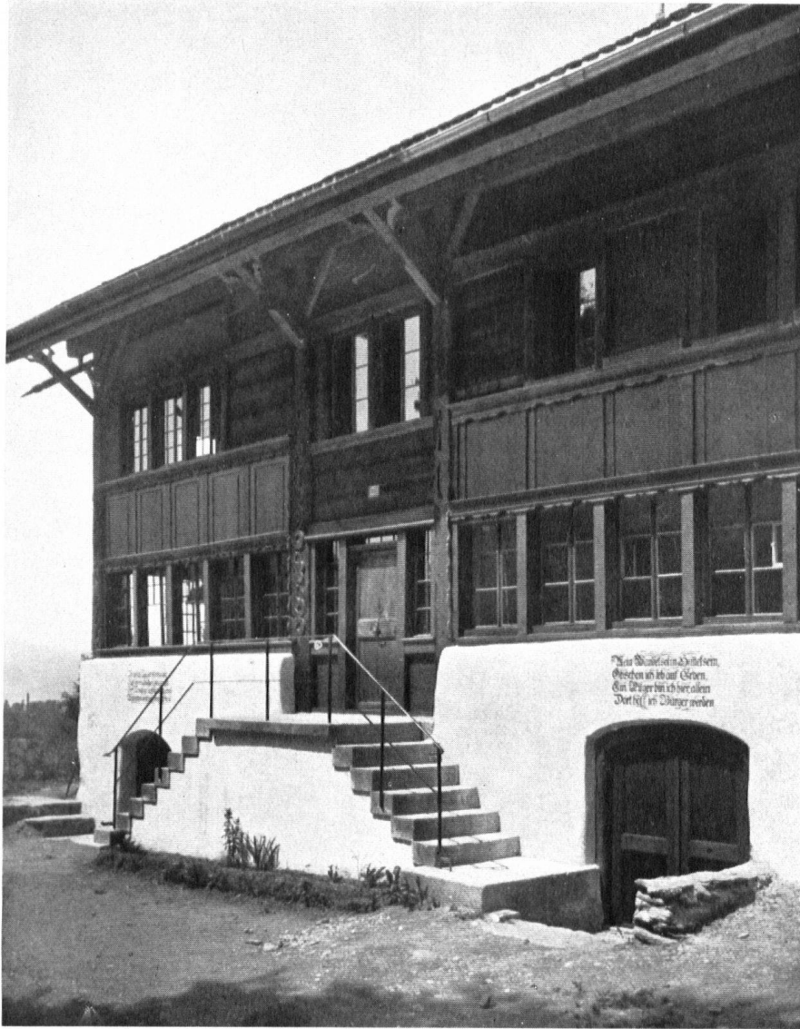
Seitenansicht des erneuerten Pilgerwirthshauses «Zum alten Schwert». Über den Fenstern des Erdgeschosses die typischen Zürcher Oberländer Falläden.
