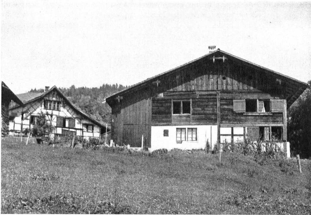
Das alte Pilgerwirthshaus zu Blattenbach (rechts) bildet mit den alten Bauernhäusern eine malerische Baugruppe.
