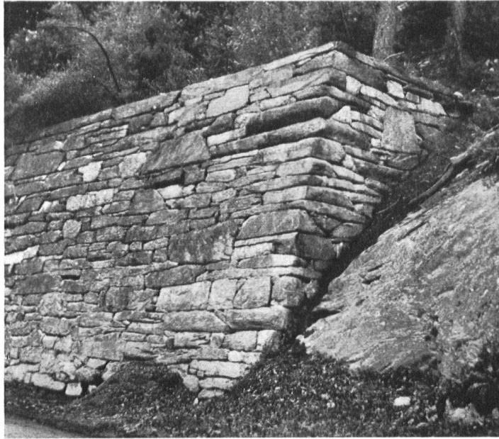
Meisterhaftes Trockenmauerwerk aus Phyllit aus der Mitte des 19. Jahrhunderts vom Arlberg. Magistral mur en pierre sèche (milieu du XIXe siècle), dans l'Arlberg.
