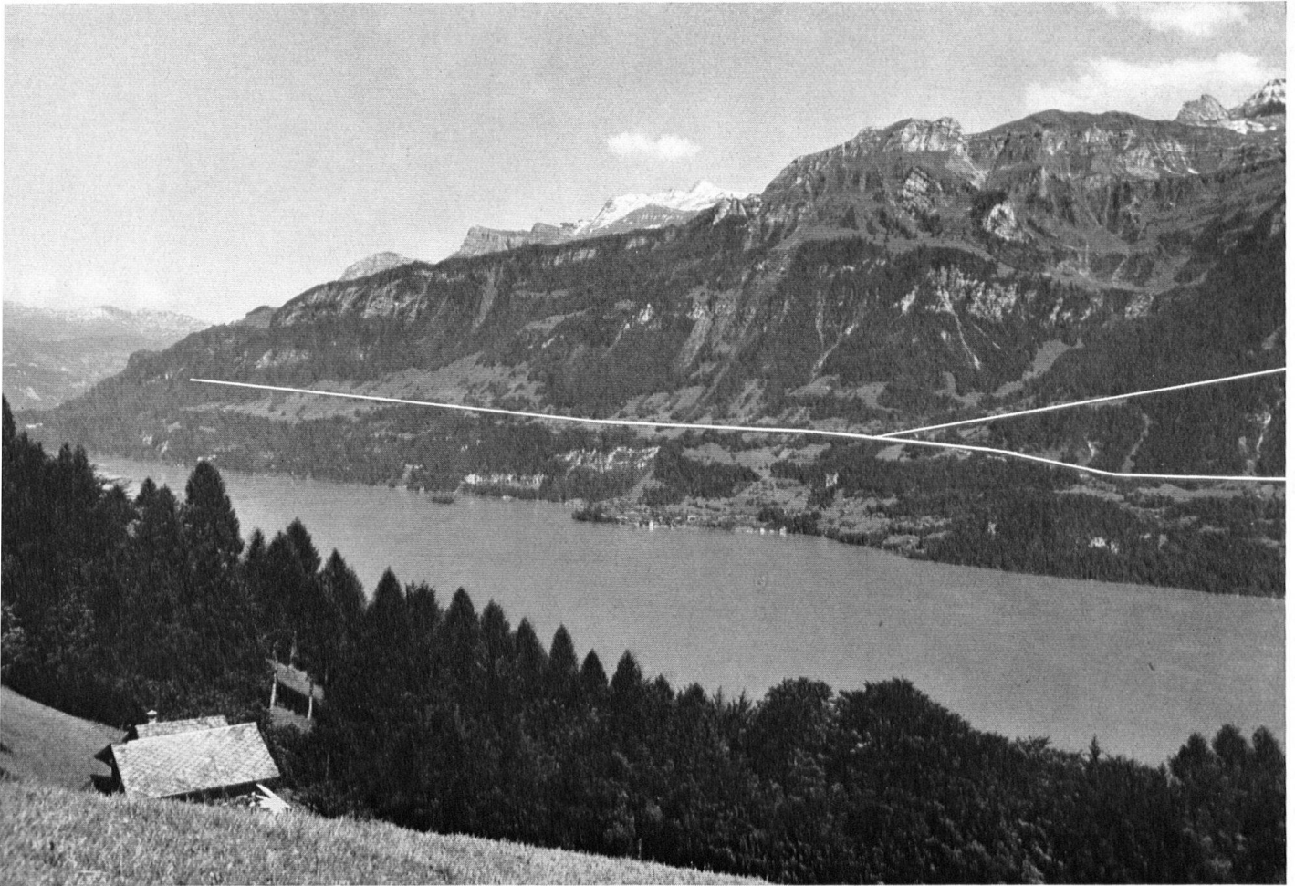
Voraussichtliche Leitungsführung am Brienzensee. Die obere Linie zeigt eine Variante. Zur Ausführung wird wahrscheinlich die untere kommen. Da sie durch stärker bewohnte und begangene Gegenden führt, ist sie vom Gesichtspunkte des Heimat- und Naturschutzes aus die schlimmere. Vue générale de la conduite électrique sur les rives du Lac de Brienz. La ligne supérieure indique une variante possible; mais c'est, hélas, le tracé inférieur qui risque de l'emporter. Traversant des
