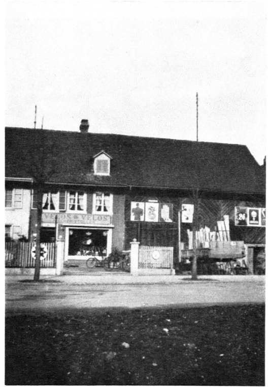
Töss mit seinen verklebten Häusern. — Avant d'arriver à Winterthour, encore des maisons et des granges recollées de réclames.
