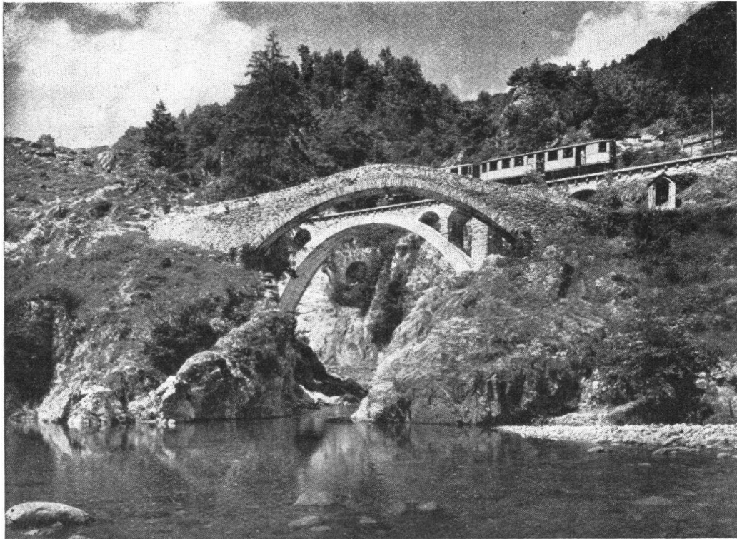
Abb. 1. Brücken im Centovalli, Tessin. Vorn eine alte Steinbrücke mit beidseitig ansteigender Fahrbahn; hinten die neue Eisenbahnbrücke mit Betongewölbe und Aufbauten mit Mauerwerkverkleidung. — Fig. 1. Deux ponts dans le Centovalli, Tessin. Devant, un ancien pont de pierre à dos d'âne (rampes des deux côtés); derrière, le pont du chemin de fer avec une arche en béton.
