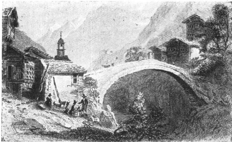
Fig. 2. Brücke zu Stalden, nach altem Stahlstich (Sammlung Curiger). Dieses hoch gewölbte Brückenjoch, weiter gespannt als das Flussbett, scheint die auseinanderstrebenden Ufer vereinen zu wollen. Die „Neubrücke“ wird gegenwärtig nicht mehr benützt. — Fig. 2. Pont de Stalden, d'après une ancienne gravure (Collection Curiger). Cette arche, plus ample que le lit du torrent, ce parapet qui s'incurve, semblent marquer l'effort à maintenir les rives escarpées. Le «Neubrücke» est actuellement abandonné.
