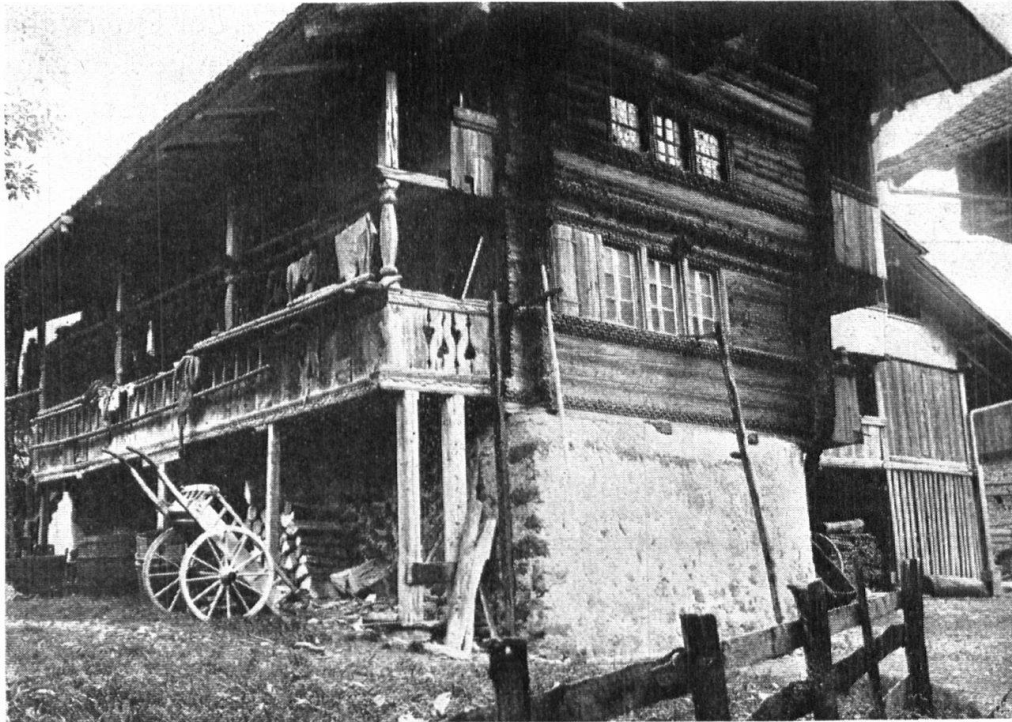
Abb. 4. Interessante und charakteristische Ornamentik, wie sie für Holzbehandlung eigen und wirkungsvoll ist. Im oberen Stockwerke dieses Hauses in Bönigen sieht man noch Fenster mit Butzenscheiben. — Fig. 4. Ornementation intéressante et d'un bon effet, caractéristique pour la manière dont on travaille le bois dans l'Oberland. A l'étage supérieur de cette maison de Bönigen, on voit encore des petites vitres rondes enchâssées de plomb.
