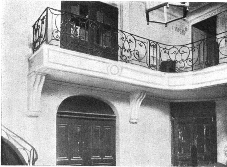
Fig. 8. Château de Dardagny. Galerie au-dessus de l'escalier principal. — Abb. 8. Schloss von Dardagny. Galerie über der Haupttreppe.
