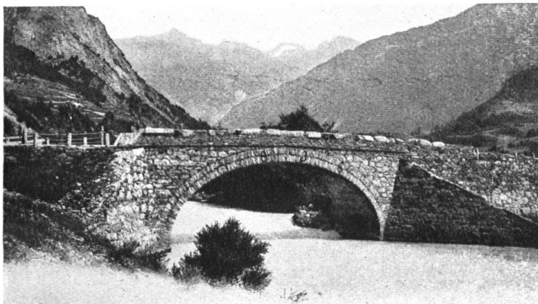
Fig. 7. Pont des Trappistes à Sembrancher. C'est le type des ponts du Val de Bagnes et d'Entremont, à arc en anse de panier: quoique plus lourds que ceux à plein cintre, ils conviennent sur les gros flots des Drances, reliant des terres riches en moisson. — Abb. 7. Die Trappisten-Brücke zu Sembrancher. Typus der Brücken im Bagnes- und Entremont-Tal. Breit gezogener Brückenbogen, in seiner etwas schweren Wirkung der Gegend wohl angepasst.
