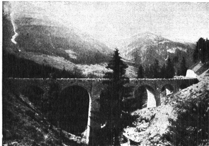
Fig. 12. Viaduc du Laxgraben de la ligne de la Furka. A lui seul, ce sapin coupe la ligne de la voie qui tranche le paysage; d'autres viendront et le site gagnera alors de la variété que lui donneront les échappées à travers les arches. — Abb. 12. Laxgraben-Viadukt der Furkalinie. Eine Tanne im Vordergrund unterbricht die herbe Linie, die die Landschaft durchschneidet, andere werden folgen und die Durchblicke abwechselnd und reizvoll gestalten.
