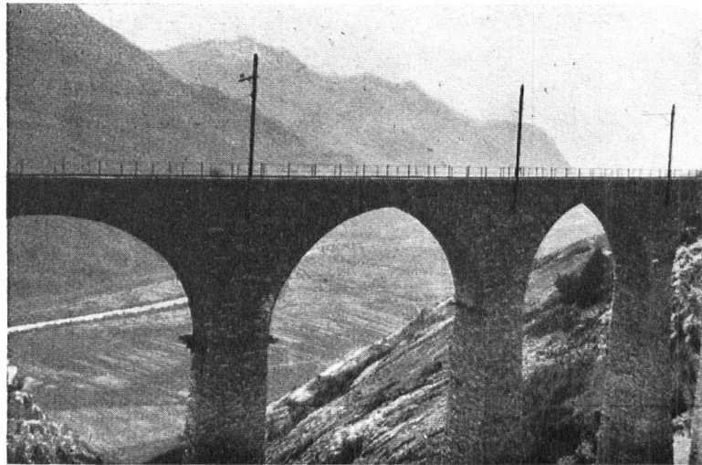
Fig. 11. Viaduc de Giesch sur la ligne du Lötschberg (Photo de l'Édition Art. Perrochet-Matile, Lausanne). Les lignes sévères et dures de ce viaduc caractérisent la grande voie internationale; elles s'harmonisent avec ce versant aride et uniforme et aux grandes silhouettes des montagnes. — Abb. 11. Giescher-Viadukt auf der Lötschberglinie. (Photo Perrochet-Matile, Lausanne). Die strengen, harten Linien dieses Viaduktes erstehen aus einem abschüssigen, rauhen Terrain und harmonisieren mit den Bergketten des Hintergrundes. Der grosse Wurf des Bauwerks wird der Bedeutung der internationalen Linie gerecht.
