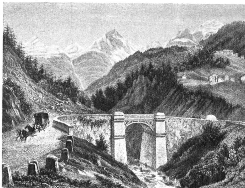
Fig. 5. Le pont de la Ganther sur la route du Simplon, d'après une gravure (collection Curiger). On peut lui reprocher une disproportion entre les lourdes culées et le léger pont de bois, ainsi qu'une recherche de « style ». — Abb. 6. Die Ganther-Brücke an der Simplonstrasse, nach einem Stich (Sammlung Curiger). Das Verhältnis zwischen der leichten Holzbrücke und den schweren Pfeilern ist nicht ganz glücklich, auch wirkt die künstlerische Gestaltung zu wenig einheitlich, zu absichtlich.
