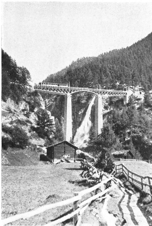
Fig. 13. Pont de Findelen de la ligne du Gornergrat. (Photo Wehrli S. A. Kilchberg.) Un joli paysage enlaidi par ce treilli de ferraille dont les lignes et les proportions sont disgracieuses. — Abb. 13. Findelenbrücke auf der Gornergratlinie. (Photo Wehrli A. G., Kilchberg). Eine reizvolle Landschaft wird durch die Eisengitter dieser fliegenden Brücke entstellt. Linien und Proportion der Eisenkonstruktion sind hässlich.
