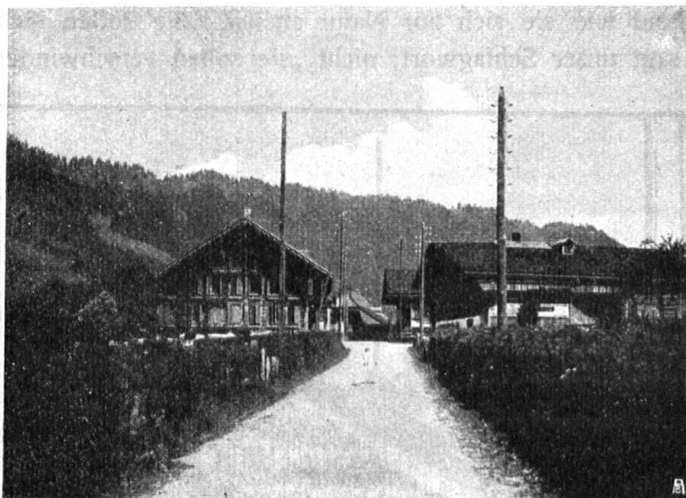
Abb. 1. Strasse bei St. Stephan im Simmental. Die Stangen im Vordergrund, besonders die rechts, geben das deutliche Bild der wünschbaren Vereinigung von Trägern und Hecken. (Die Stangen im Hintergrund nehmen leider keine Rücksicht auf die Häuser.) — Fig. 1. Route de St-Stephan dans le Simmental. Les poteaux du premier plan, surtout celui de droite, sont un bon exemple de la combinaison qu'il faudrait obtenir entre le poteau et la haie ou la clôture en bord de route. (Malheureusement, dans le village même, on n'a eu aucun égard aux maisons en plaçant les poteaux.)
