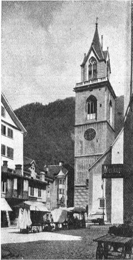
Abb. 1. Kirchturm in Chur, vor der Umgestaltung von 1918. — Fig. 1. Le clocher de Coire en 1918 avant sa transformation.
