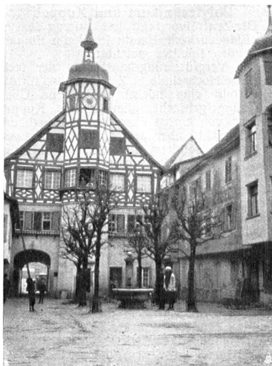
Abb. 19. Das Rathaus in Steckborn. Nach Freilegung des schönen Riegelwerkes hat der Bau seinen alten heimischen Charakter wieder erhalten. Fig. 19. L'hôtel de ville, à Steckborn. Le crépi disparu, la belle architecture en pans de bois de cette construction caractéristique a retrouvé son pittoresque d'autrefois.
