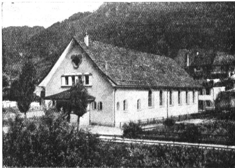
Turnhalle in Glarus, Eternit Doppeldach, schwarz engobiert
