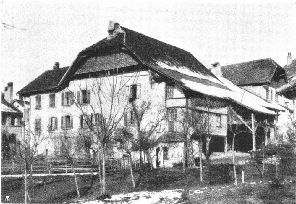
Fig. 7. Maison à St-Légier, avec le grenier et la cheminée tavillonées. Abb 7. Haus in St-Légier, mit verschindeltem Dachspeicher und Kamin.
