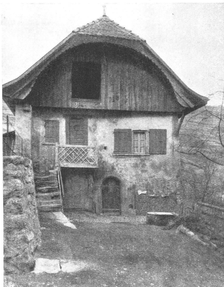
Fig. 4. Maison à Rivaz, avec toit bernois sur socle savoyard. Abb. 4. Haus zu Rivaz, mit Berner Dach auf savoyischem Unterbau.
