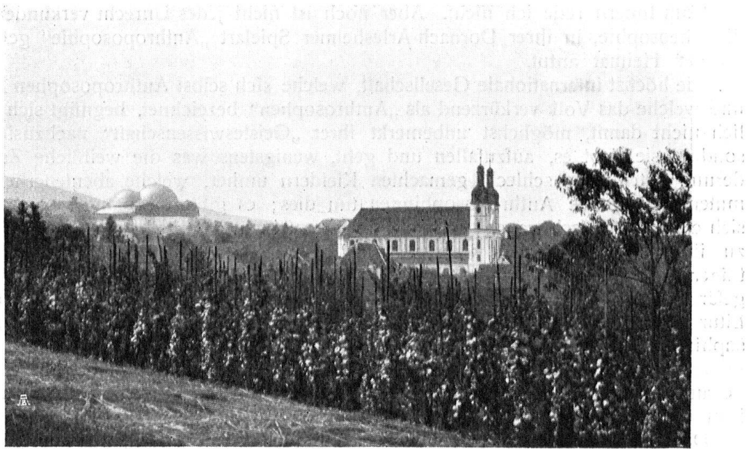
Abb. 14. Domkirche und „Johannesbau“. Gutes und schlechtes Beispiel: Gediegene, massvolle Baukunst und effekthaschende Dilettantenarchitektur — leider auf einem Bilde in einer Landschaft! Aufnahme von J. Grieder, Arlesheim. — Fig. 14. La cathédrale et le „Temple“ des anthroposophes. Parallèle d'une bonne et d'une mauvaise architecture: l'une simple et d'un goût excellent, l'autre énorme, prétentieux, et cela, malheureusement, dans le même paysage.
