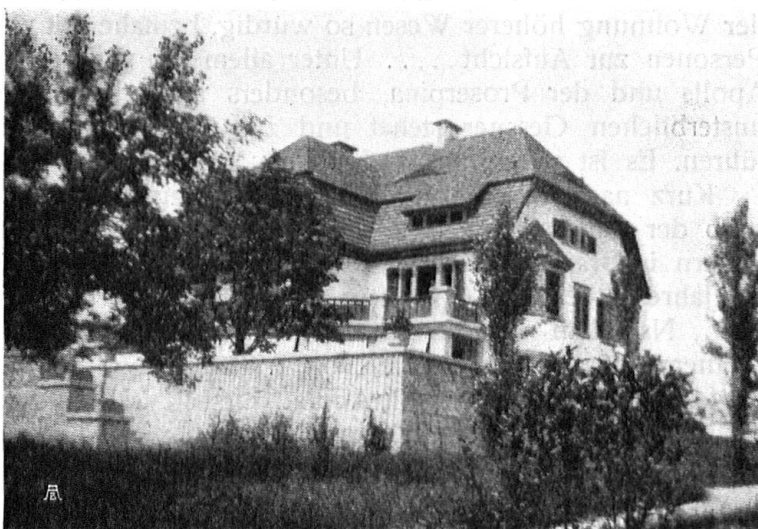
Abb. 10. Landhaus „Weisses Segel“ (Architekt Daniel Alfr. Bernoulli, Arlesheim). Aufnahme von Emanuel Sarasin. — Fig. 10. Maison de campagne „Weisses Segel“ (La voile blanche), architecte M. Daniel Alfr. Bernoulli, à Arlesheim.
