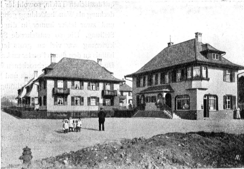
Abb. 14. Wohnhausgruppe in Rapperswil, mit rechteckigen Eternit-Plättchen eingeschindelt. Fig. 14. Groupe de maisons avec revêtement de petites plaques d'éternite quadrangulaires.
