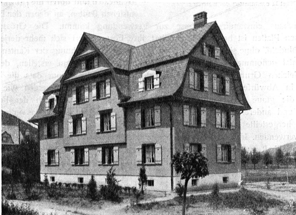
Abb. 15. Wohnhaus in Niederurnen. Eternitwandbelag mit abgerundeten Ecken.— Fig. 15. Maison d'habitation à Niederurnen. Revêtement d'éternite, plaques arrondies aux angles.
